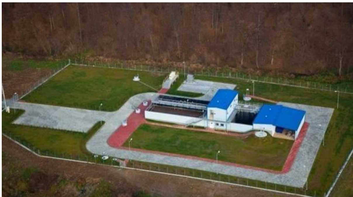
Rysunek 30. Oczyszczalnia ścieków w Nowym Żmigrodzie
