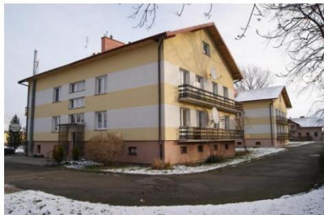
Fot. 11. Konieczne ciągi komunikacyjne
