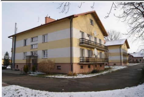
Fot. 31. Konieczne ciągi komunikacyjne
